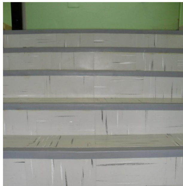
Reforma da Escada
